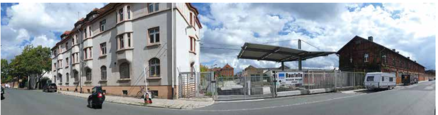
Eine ganze Reihe entlang der Weißenburgstraße unter Denkmalschutz: Angefangen mit dem Offiziersbau 7108, dem einstigen Arbeitsplatz von Claus Schenk Graf von Stauffenberg mit den markanten Erkern links.
