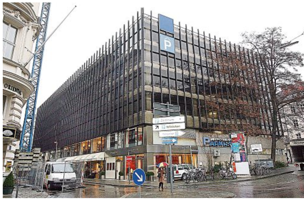
Das Fina-Parkhaus an der Hildegardstraße ist dem Abriss geweiht.
